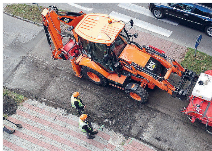
Wszystkie pęknięcia i dziury, które powodowały wstrząsy ponad stuletniego budynku, zostały usunięte.
